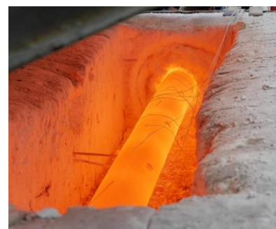
Strahlheizrohr im Versuchsbetrieb
